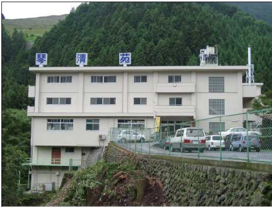
琴清苑前景（駐車場横の木を伐採後撮影）
