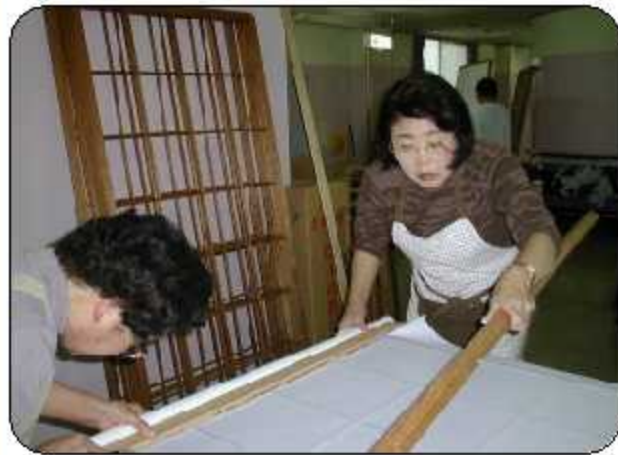
障子張りの様子
